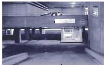
海安路地下停車場遠景圖
