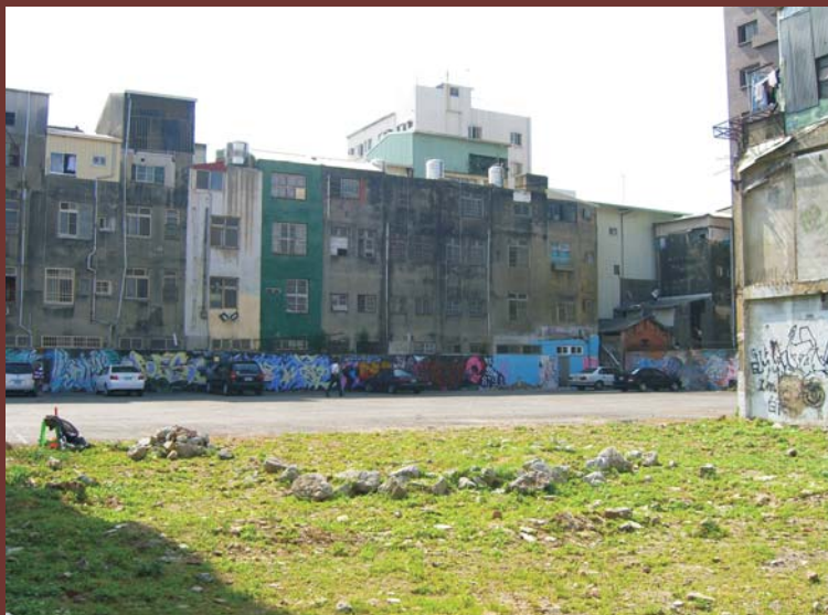
基地現況照片
